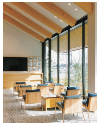
間伐材を建材として活用した子飼橋支店
