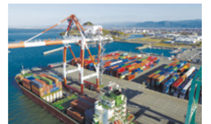
八代港コンテナヤード
