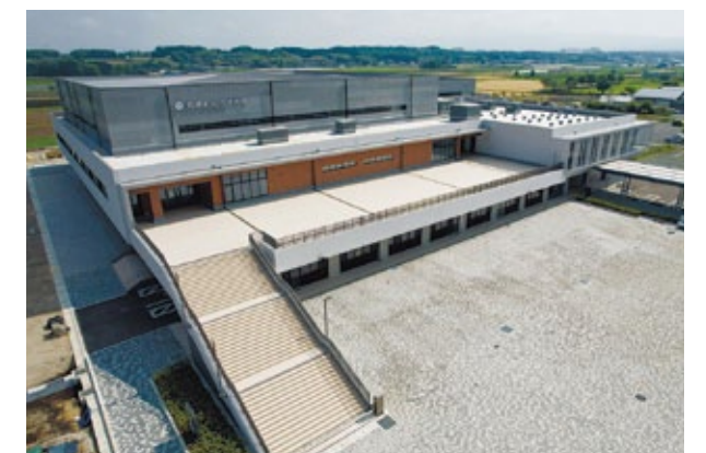
菊陽町総合体育館(令和5年10月供用開始予定)
