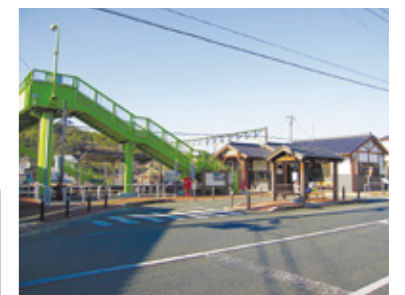
エレベーター新設予定の木葉駅
