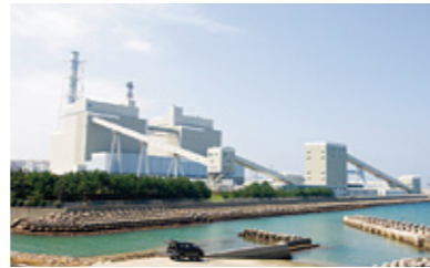
九州電力苓北発電所
