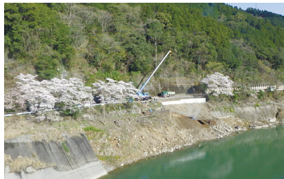
国道219号の復旧の様子(八代市坂本町)
