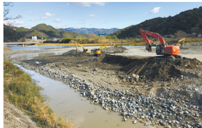
河道掘削(川辺川)の様子(相良村)
