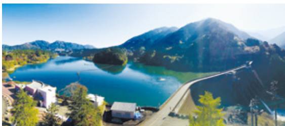
ダム周辺の写真
