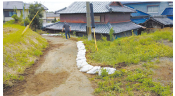
豪雨被害の復旧の様子
