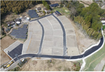
被災者向け住宅団地の造成(塚ノ丸団地)
