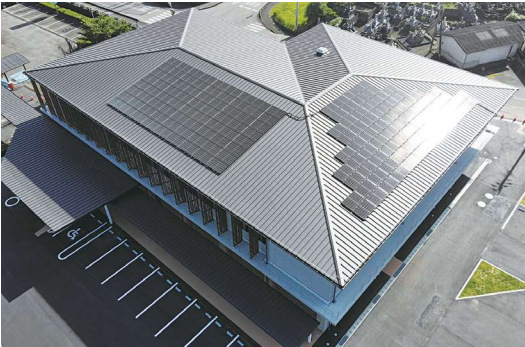
あさぎり町役場新第二庁舎に設置された太陽光パネル
