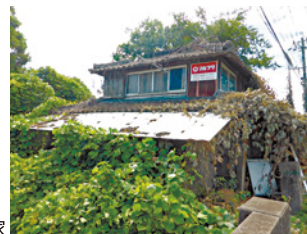
放置された空き家
