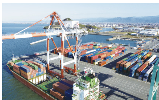
八代港コンテナヤード
