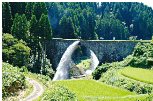
国宝に指定された通潤橋
