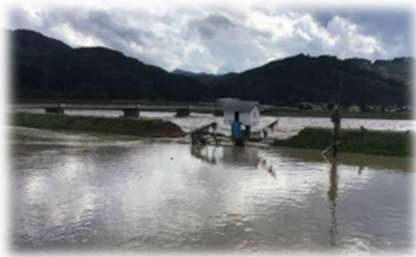
7月4日15時 堤防の決壊を確認
