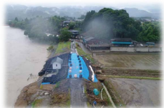
7月6日9時 応急復旧完了
